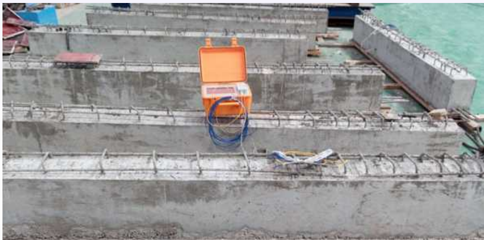
案例1 混凝土结构健康监测
